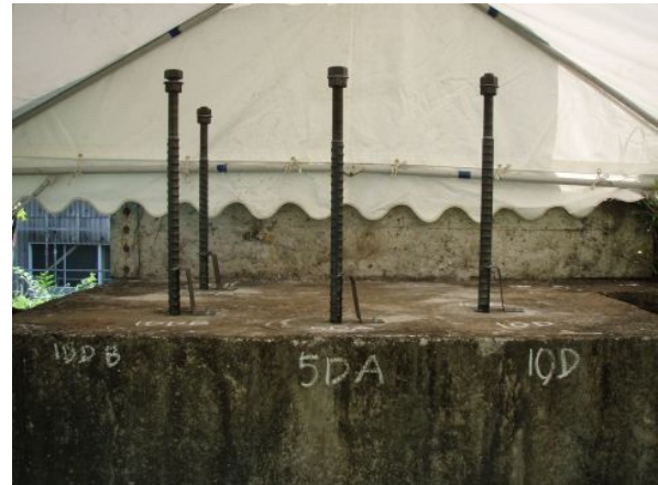
写真—3 試験に用いたアンカーボルト（躯体1）
