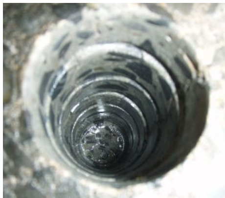
写真—2 溝切削孔後の孔内の状況を示す
